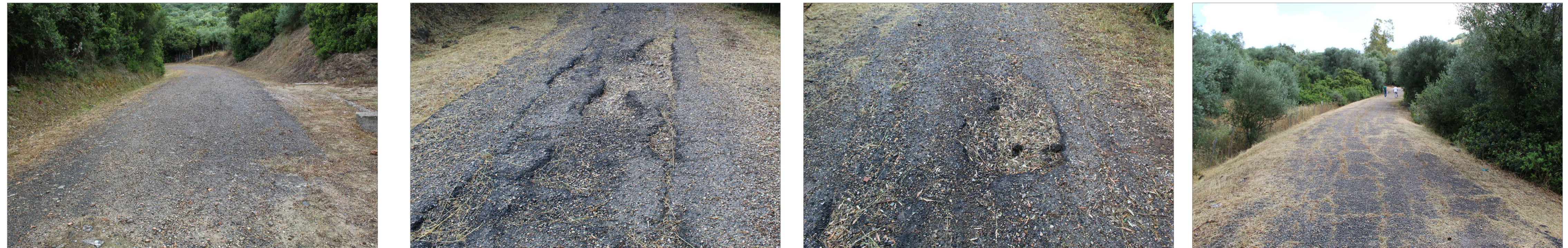
FOTO STATO DI FATTO _ MANTO STRADALE
